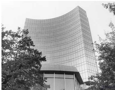
Bâtiment de l'OMPI à Genève
